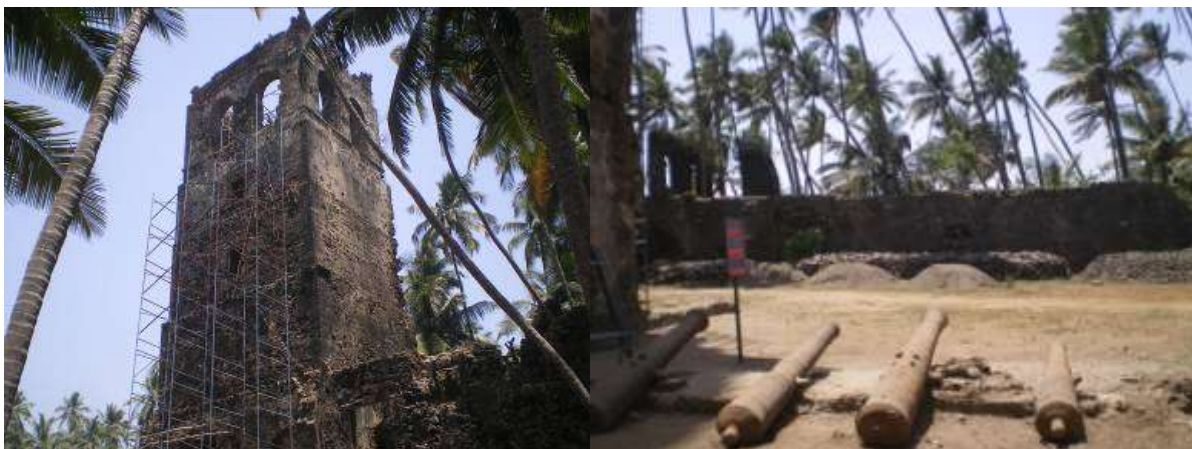
Trabalhos no Convento de São Francisco de Chaúl, Abril de 2010
