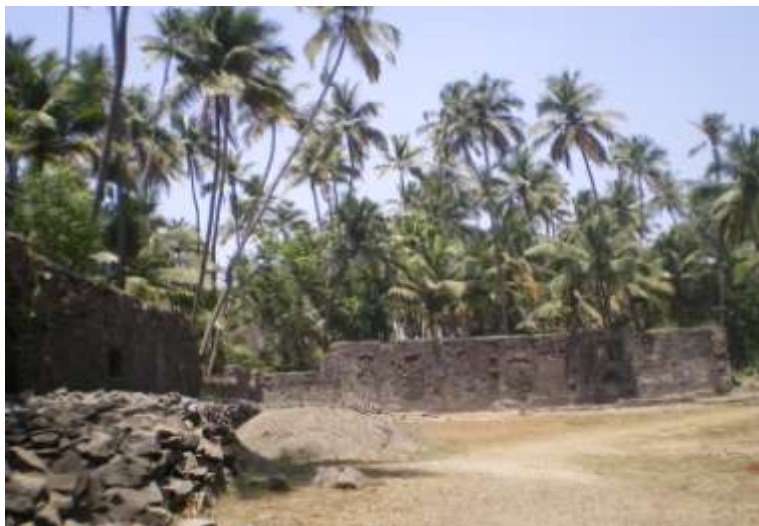
Trabalhos no Convento de São Francisco de Chaúl, Abril de 2010
